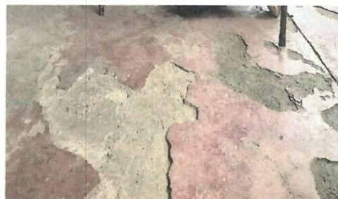
Foto 6: sustitución de piso Cerámico, en el sala de Segundo básico
