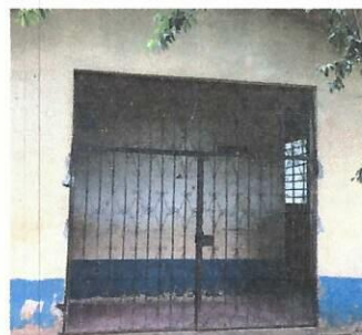
Foto 2: Se colocará portón de metal en el salón para mayor seguridad
